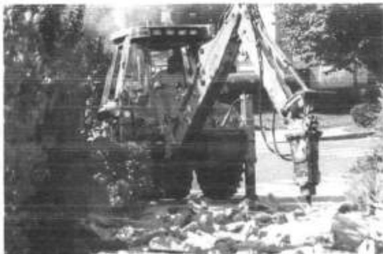
Премахване на съществуващи настилки
